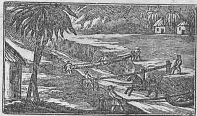
ΚΡΕΜΑΣΤΑΙ ΓΕΦΥΡΑΙ ΤΩΝ ΙΜΑΛΑΙΩΝ.
